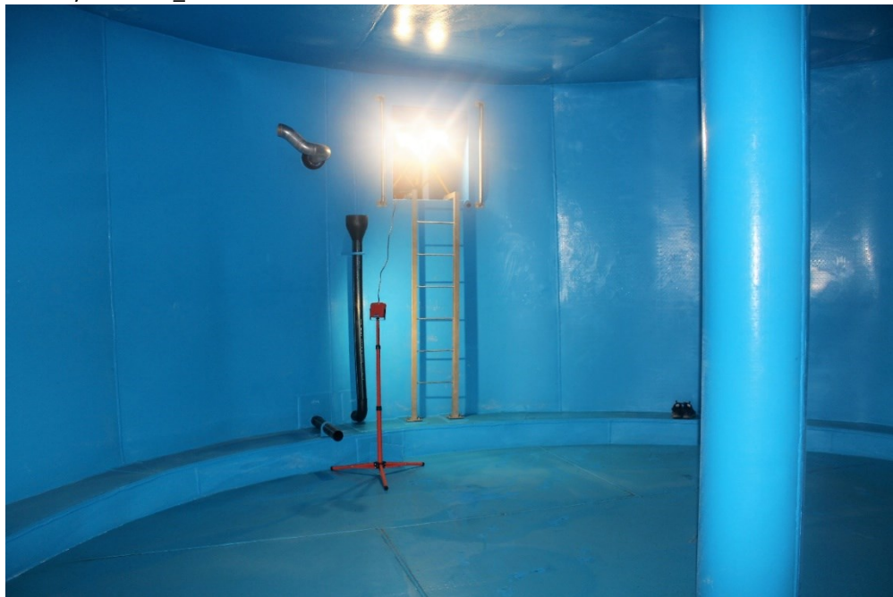
Vodojem Drnholec, Okres Břeclav
